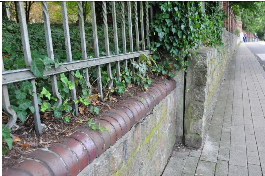
Fot. 5 Ogrodzenie na odcinku na wschód od bramy: rozspojenie muru w części cokołowej: widok od strony starszego odcinka ogrodzenia.
