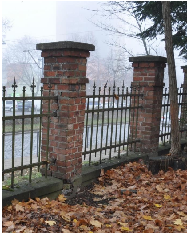
Fot. 13 Zły stan zachowania ceglanego słupa: ubytki cegły w podstawie, głębokie pęknięcia w miejscu osadzenia metalowego przęsła. Drzewo rosnące w zbyt małej odległości od ogrodzenia.
