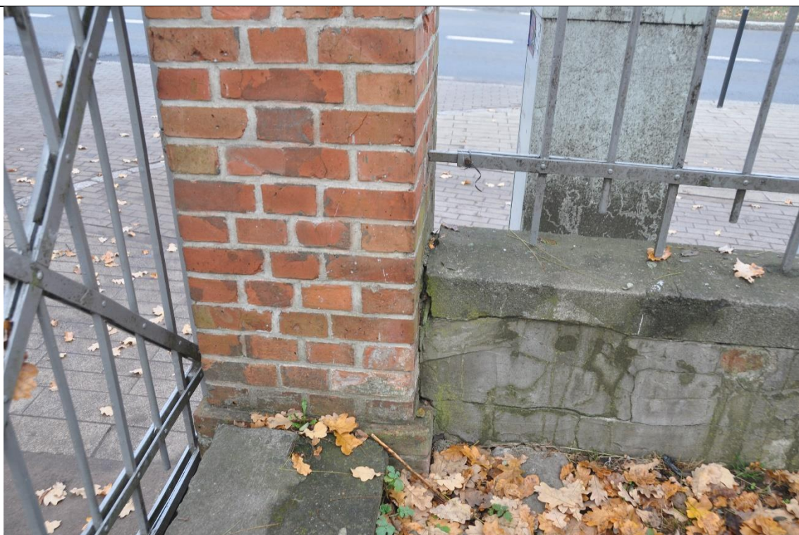
Fot. 10 Zły stan zachowania szlichty pokrywającej mur od strony cmentarza.
