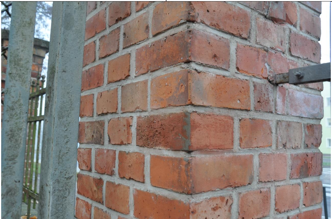
Fot. 17 Brama nr 2. Nowe spoinowanie słupów. Oczyszczona powierzchnia cegły.
