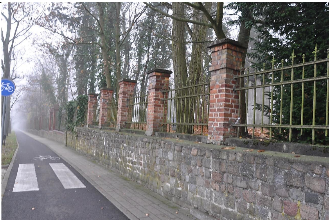
Fot. 9 Ogrodzenie Cmentarza Centralnego w Szczecinie, od strony ul. Ku Słońcu. Przęsła sąsiadujące od wschodu z bramą nr 2 (naprzeciwko ul. Karola Miarki). Filary uzupełniane cegłą klinkierową.
