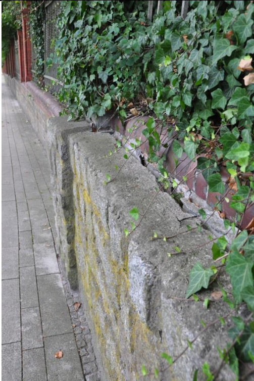
Fot. 3 Ogrodzenie na odcinku na wschód od bramy: rozspojenie muru w części cokołowej.
