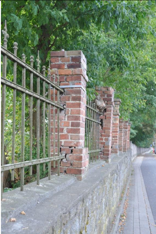
Fot. 6 Słup po zachodniej stronie bramy nr 2. Konstrukcja wymagająca przemurowania ze względu na pęknięcia.
