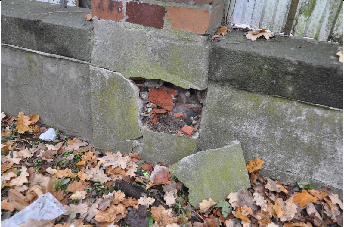
Fot. 11 Zły stan zachowania części cokołowej ogrodzenia. Całkowicie zdegradowana cegła, znajdująca się pod spękaną betonową szlichtą. Cegła uległa całkowitej erozji na skutek przemarzania.
