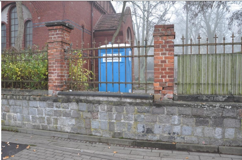
Fot. 8 Słup po wschodniej stronie bramy nr 2. Uszkodzona podstawa, brak betonowej czapki.
