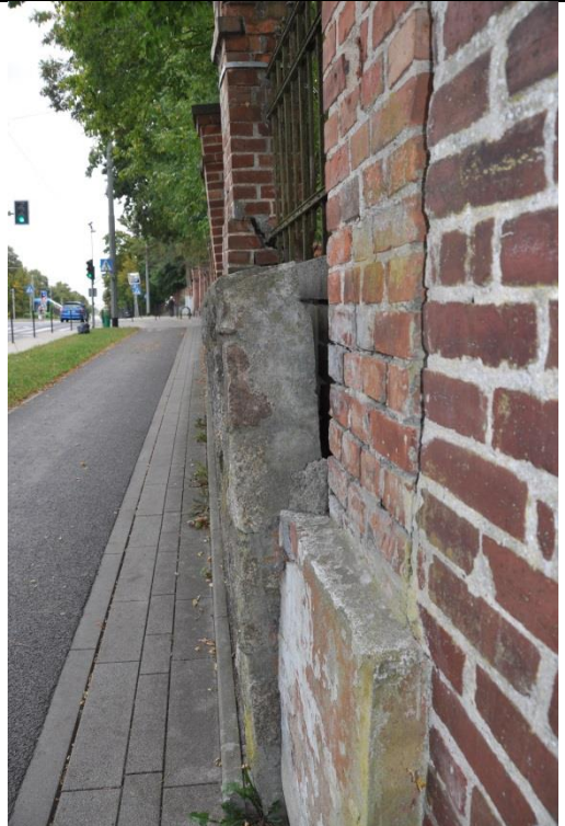
Fot. 4 Ogrodzenie na odcinku na zachód od bramy: rozspojenie muru w części cokołowej.
