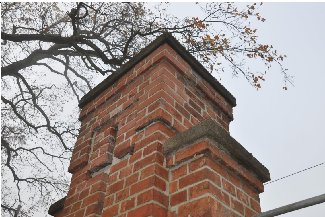
Fot. 18 Brama nr 2. Nowe spoinowanie słupów. Oczyszczona powierzchnia cegły. Górny narożnik wymurowany z nowej cegły.
