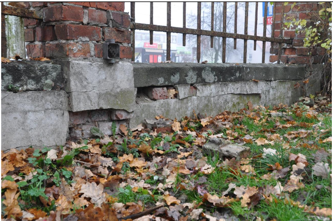
Fot. 12 Zły stan zachowania części cokołowej ogrodzenia.
