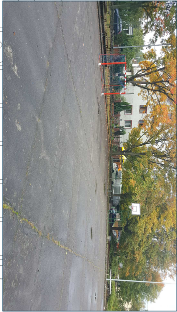
NAWIERZCHNIA BOISKA- asfaltowa Naprawa i pokrycie nawierzchnią poliuretanową wg specyfikacji
