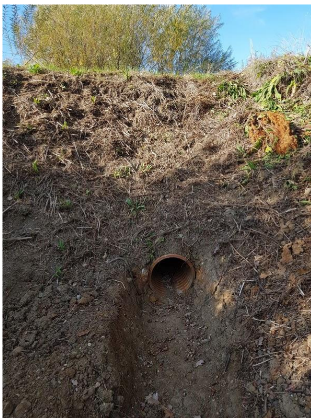
Fot. 7 Widok na istniejący przepust pod nasypem.
