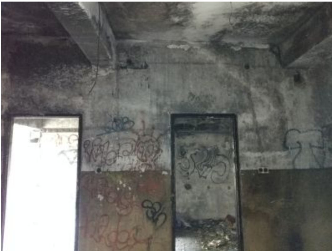
Zdj. nr 33 Strop i podciąg w pomieszczeniu narożnym południowo-zachodnim. Stan konstrukcji dobry. Tynki na ścianach i stropach do wymiany w 50 %
