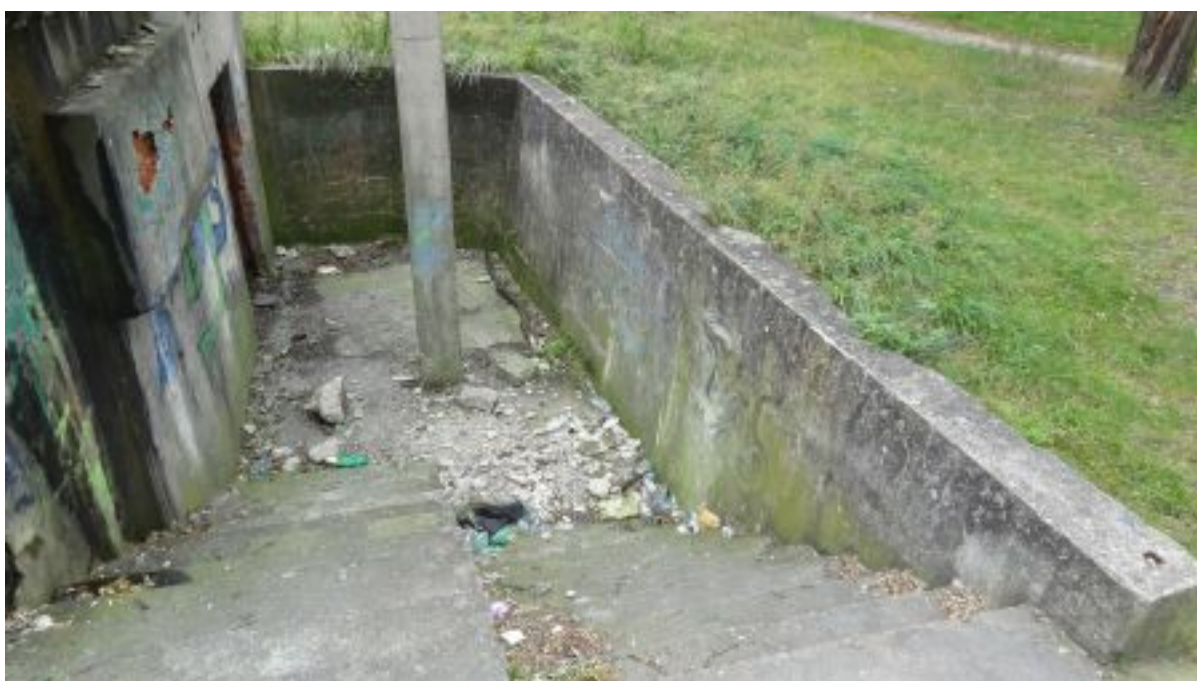
Zdj. nr 18 Schody do fosy północnej z żelbetową ścianą oporową. Schody posiadają niewielkie ubytki, ściana oporowa posiada nieduże spękania i uszkodzenia po niefachowym demontażu stalowych balustrad (wykruszenia betonu w miejscach gdzie montowano zamontowane były słupki). Posadzka betonowa zniszczona do wymiany.
