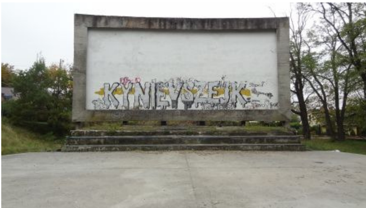
Zdj. nr 1 Żelbetowy ekran od frontu. Konstrukcja żelbetowa z uszkodzeniami spowodowanymi przez warunki atmosferyczne i brak zabezpieczeń przeciwko zawilgoceniu.
