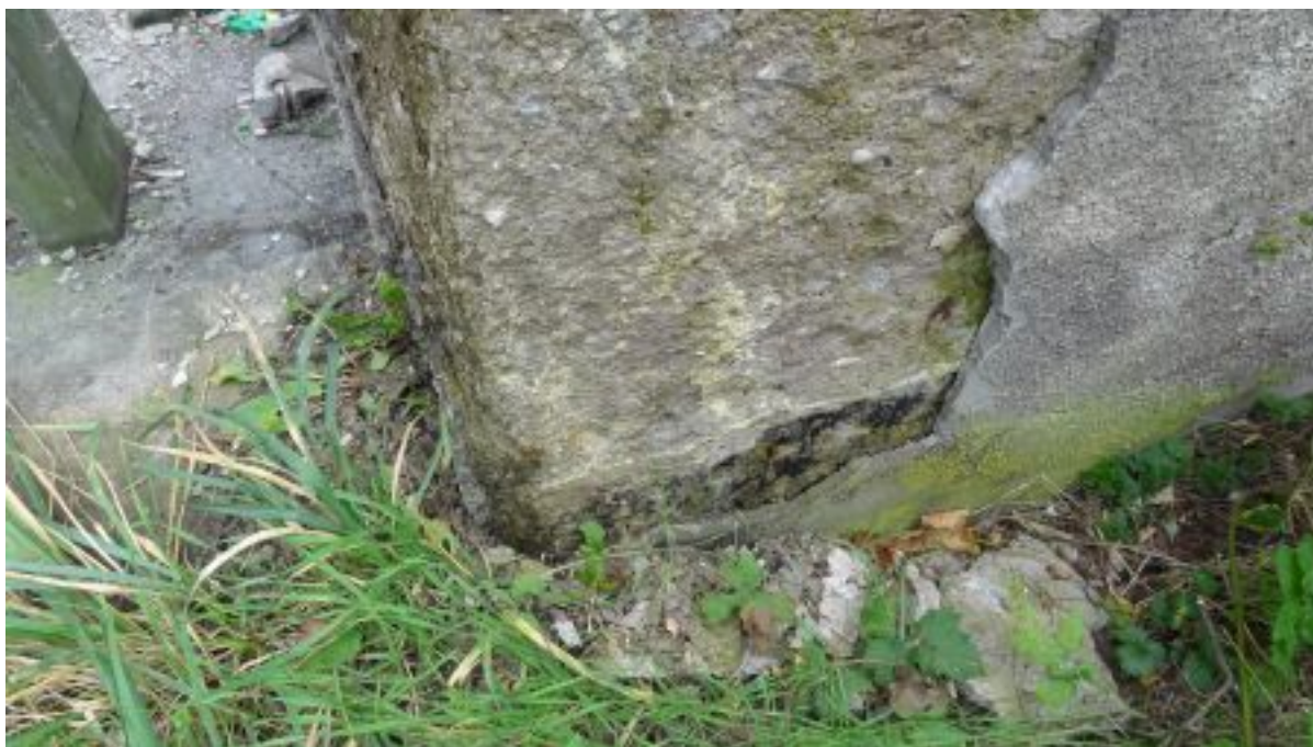
Zdj. nr 24 Narożnik północno-zachodni podscenia. Przy gruncie widoczna jest zniszczona lekka izolacja bitumiczna.
