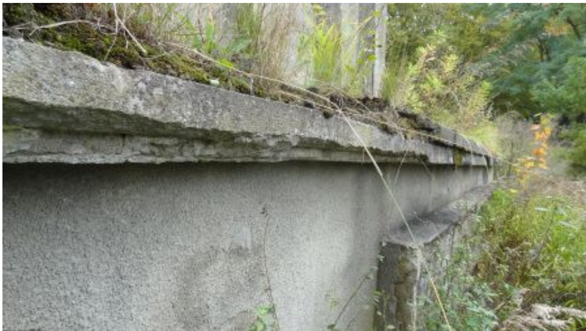
Zdj. nr 26 Zniszczone krawędzie stropu wraz ze zbrojeniem obwodowym, wymagają odtworzenia. Grubość żelbetowego stropu konstrukcyjnego wynosi 12 cm.
