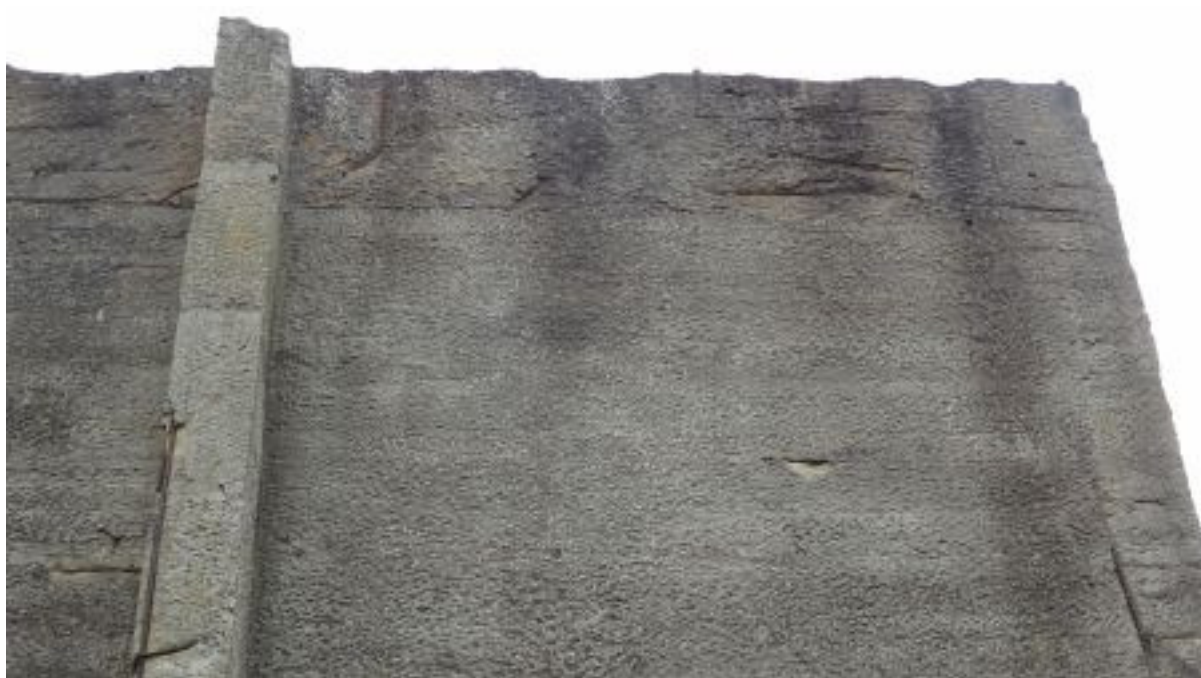
Zdj. nr 10 Tył ekranu od ul. Warsztatowej, narożnik od strony południowej. Widoczne skorodowane zbrojenia i miejscowe ubytki betonu. Widoczna erozja górnych partii ekranu.
