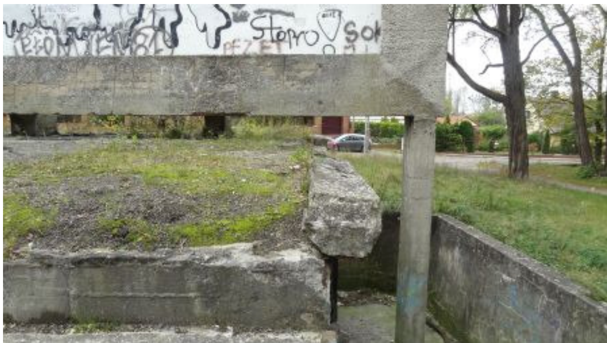
Zdj. nr 16 Północno wschodni narożnik stropu podscenia. Attyka od strony północnej jest odspojona od stropu i będzie wymagała odtworzenia, podobnie jak wszystkie obwodowe krawędzie stropu.
