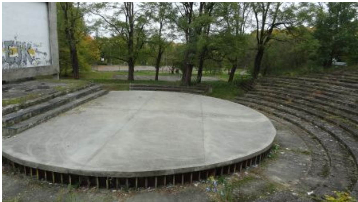
Zdj. nr 36 Scena amfiteatru. Nawierzchnia sceny była wykonana kilka lat wcześniej i znajduje się w dobrym stanie. Posiada rysy widoczne na powierzchni, brak ubytków.
