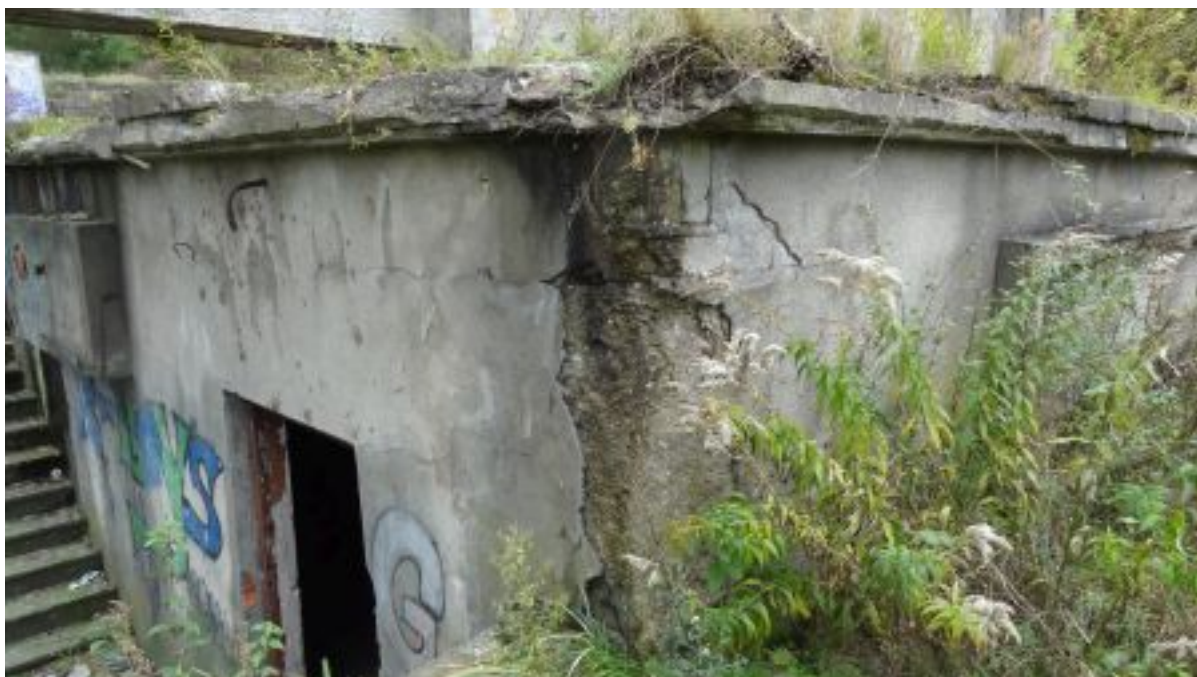
Zdj. nr 23 Narożnik północno-zachodni podscenia uległ częściowej erozji w wyniku spływu wód opadowych z dachu podscenia. Żelbetowe ściany podniesiono przez domurowanie dwóch warstw bloczków betonowych. Linia łączenia jest widoczna jako pozioma rysa ok 40 cm poniżej spodu stropu żelbetowego. Zniszczone krawędzie stropu wraz ze zbrojeniem obwodowym, będą wymagały odtworzenia.
