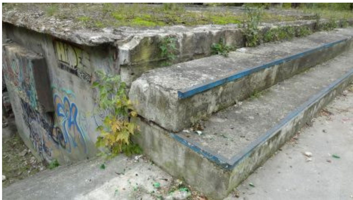
Zdj. nr 35 Dwa stopnie między sceną a stropem podscenia wykonano jako betonowe z narożnikami z kątowników stalowych. Od strony południowej stopnie betonowe są odspojone od ściany podscenia. Stopnie nie spełniają norm dla schodów. Na elewacji południowej podscenia
