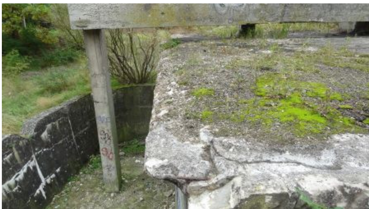
Zdj. nr 17 Południowo - wschodni narożnik stropu podscenia. Krawędź od strony południowej jest mocno zerodowana i będzie wymagała reprofilacji.
