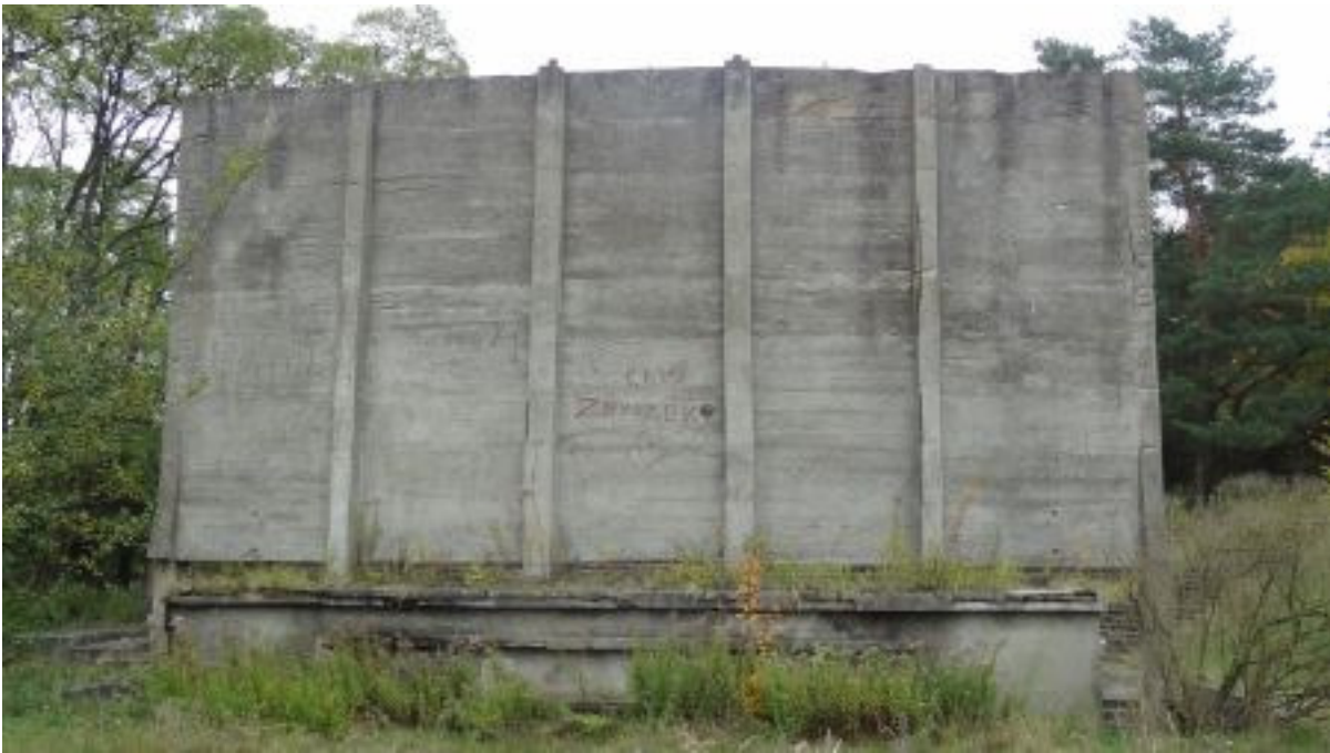
Zdj. nr 13 Widok ekranu od strony ul. Warsztatowej. Na całej powierzchni widoczne są uszkodzenia wierzchniej warstwy betonu licowego oraz głębsze ubytki na koronie ekranu oraz w okolicach zbrojeń.
