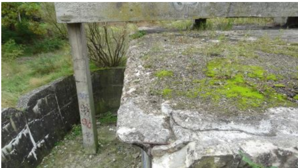
Zdj. nr 17 Południowo - wschodni narożnik stropu podszenia. Krawędź od strony południowej jest mocno zerodowana i będzie wymagała reprofilacji.
