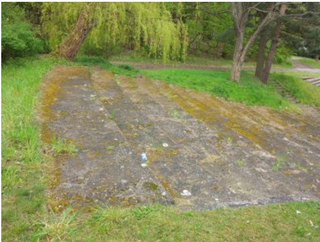
Zdj. nr 40 Południowa korona widowni głównej. Schody pokryta glonami, posiadające ubytki w betonie.
