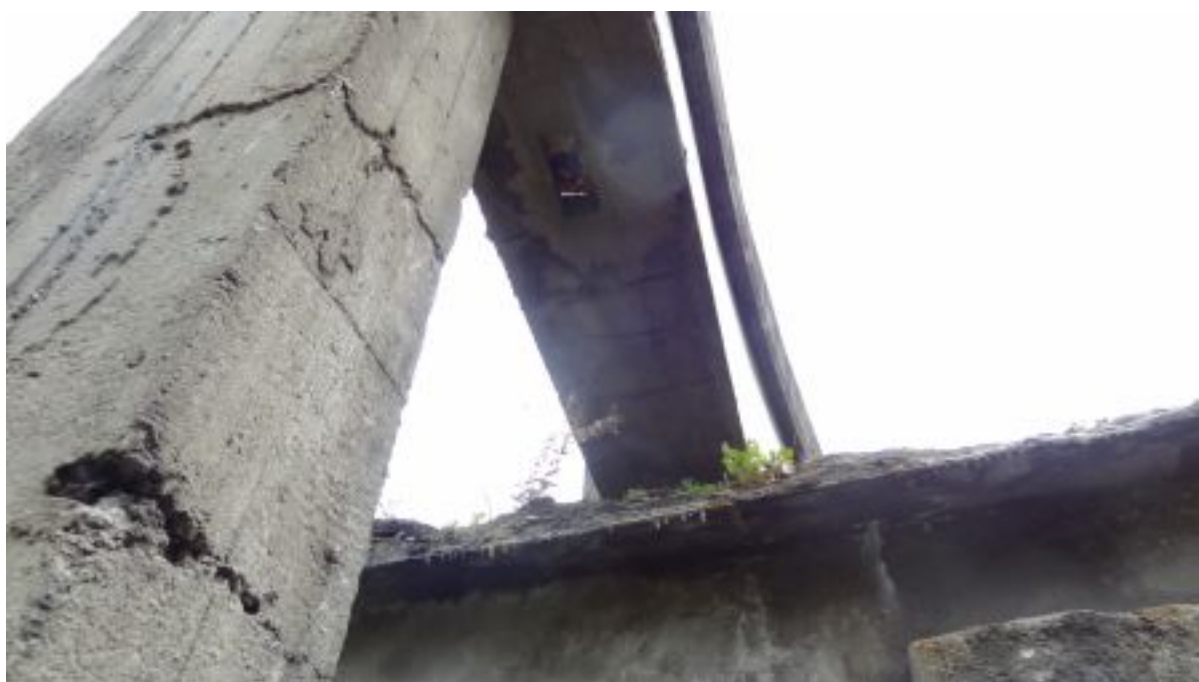
Zdj. nr 12 Słup ekranu od strony południowej od strony widowni. Na skutek wadliwie wykonanego szalunku i betonowania, nastąpiła korozja zbrojenia. Widoczna południowa krawędź dachu nad pomieszczeniami magazynowymi, uległa mocnej destrukcji i będzie wymagała odtworzenia. Zbrojenie obwodowe jest prawie całkowicie skorodowane.
