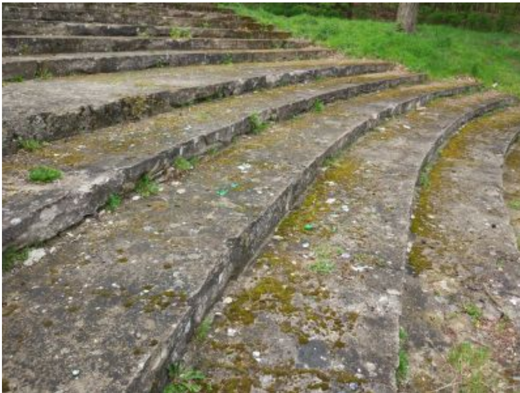
Zdj. nr 39 Południowa część trybuny głównej. Widoczna erozja betonu szczególnie na podstopnicach.
