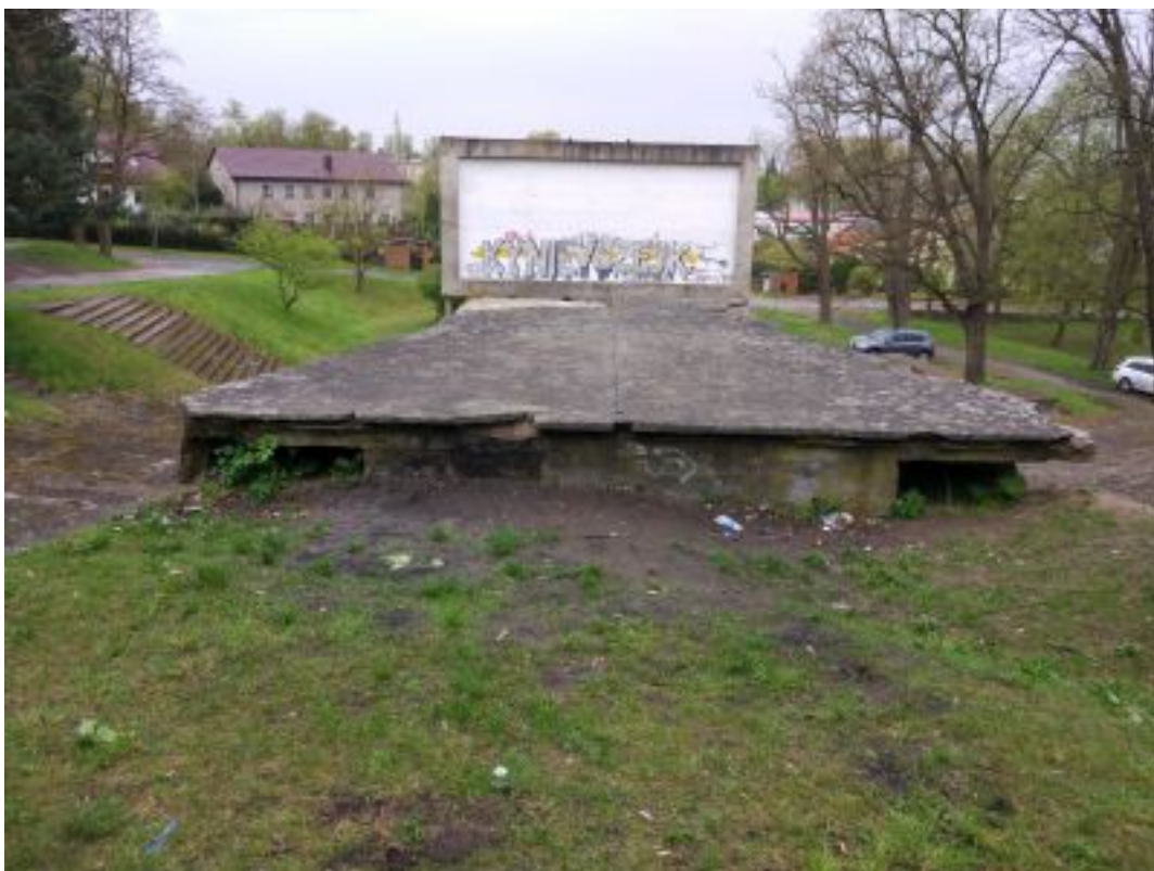
Zdj. nr 48 Projektownia - dach. Duże ubytki w grubości płyty nośnej dachu.
