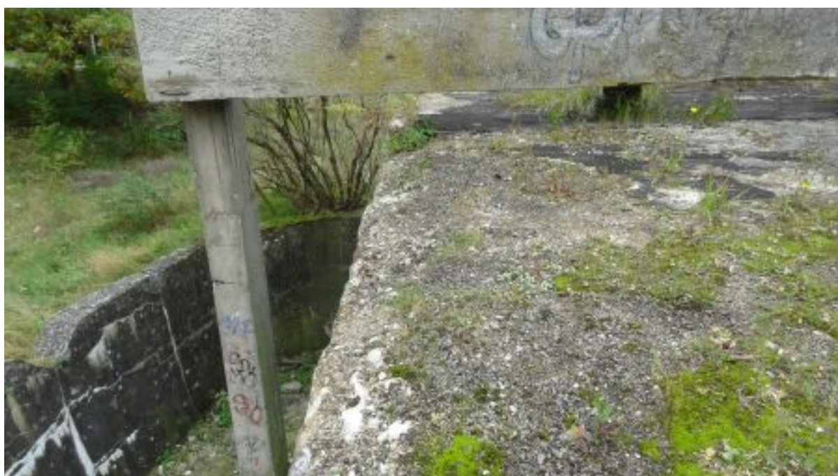
Zdj. Nr 2 Południowy żelbetowy słup podpierający ekran posiada uskok wynikający ze złego wykonania szalunków. Na stropie podscenia widoczne resztki pokrycia dachowego i skorodowane wierzchnie warstwy podkładu betonowego pod papą.
