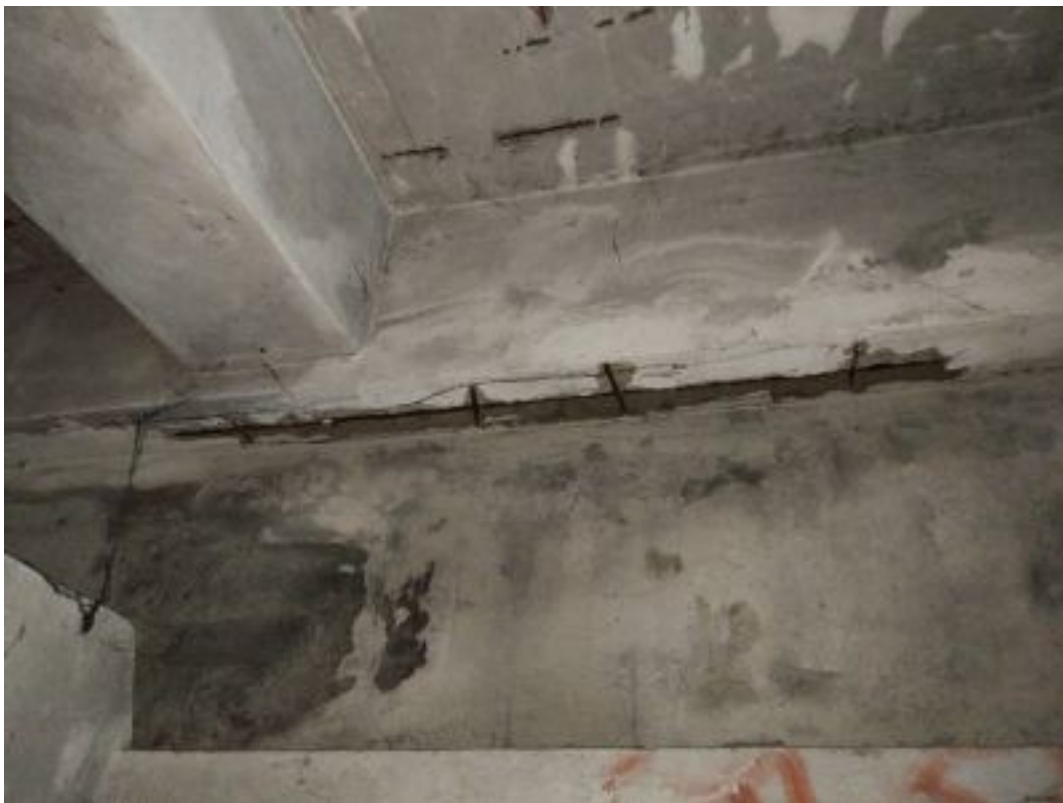
Zdj. nr 30 Podciąg nad byłym otworem okiennym na ścianie zachodniej uległ zawilgoceniu i powierzchniowemu odspojeniu otuliny z częściową korozją zbrojenia.
