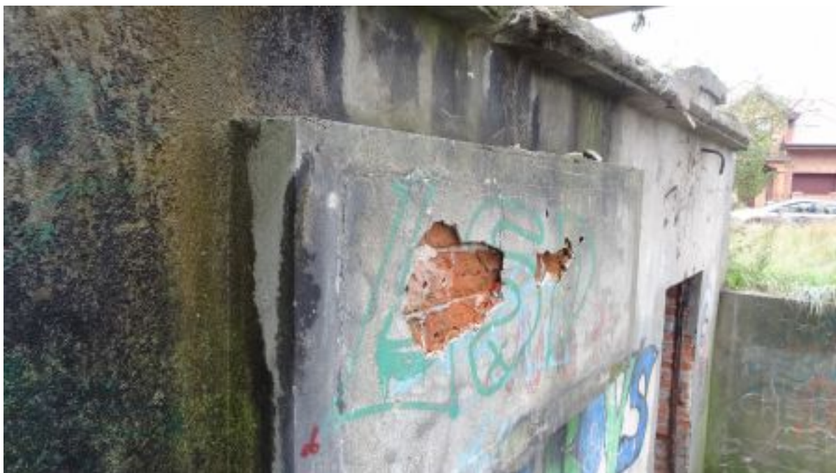
Zdj. nr 27 Północna elewacja podscenia. Krawędzie płyty stropowej są mocno zdegradowane i będą wymagały odtworzenia wraz ze zbrojeniem obwodowym. Tynki cementowe częściowo odparzone. Zamurowane otwory okienne mają zniszczone wypełnienia z cegły dziurawki i nadają się do przemurowania.
