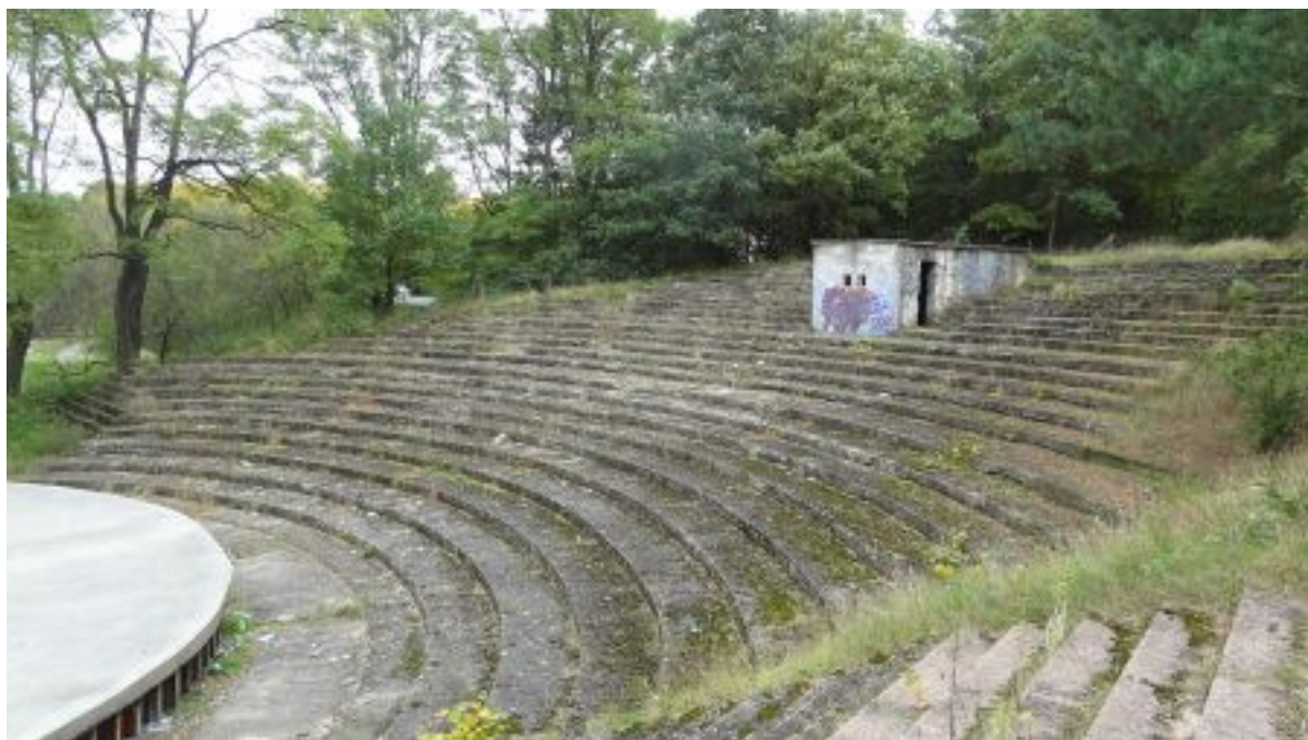
Zdj. nr 38 Trybuna główna z budynkiem projektorni. Konstrukcja betonowa wykonana na miejscu w szalunkach. Brak balustrad, stopnie częściowo uszkodzone przez mróz i wodę. W części północnej widowni, ok. 100 m 2 trybun zapadła się nawet o 20 cm. Trybuny nadają się do adaptacji jako podkład pod elementy prefabrykowane.
