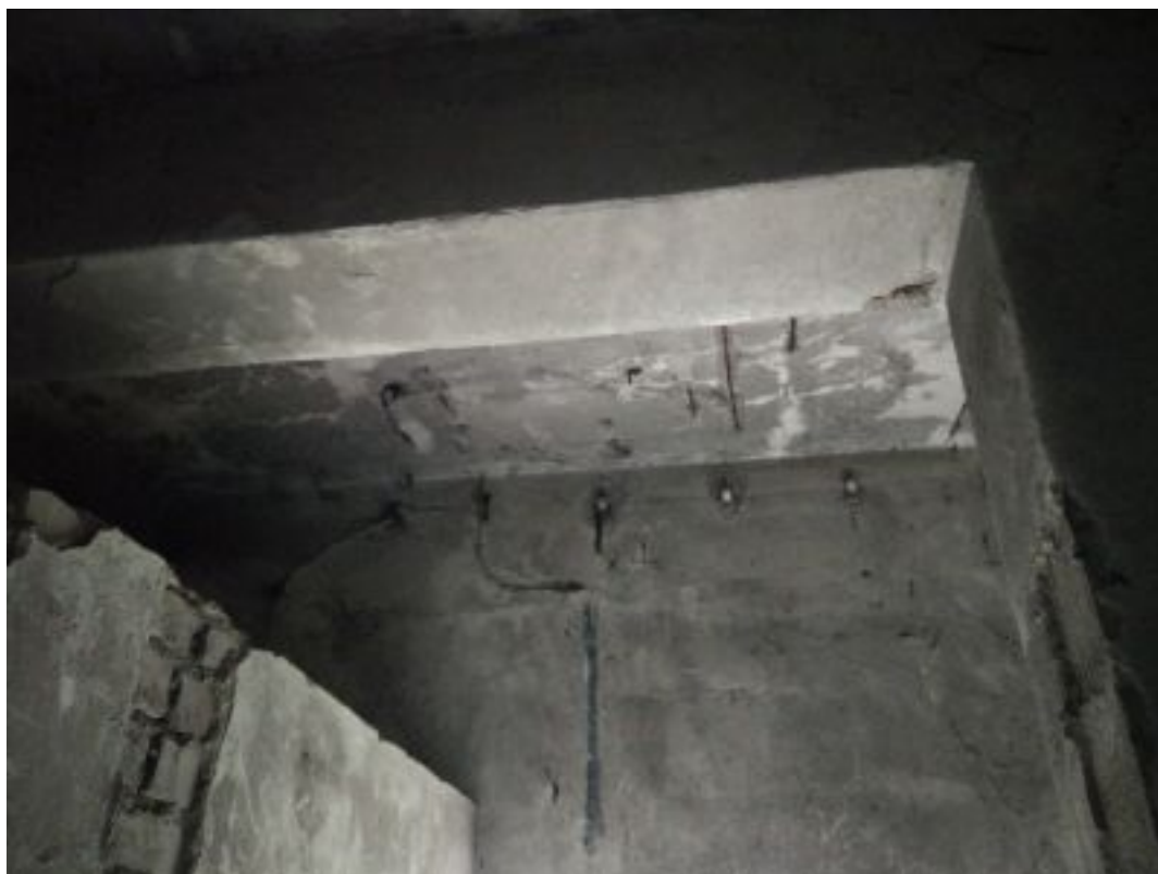
Zdj. nr 28 Podscenie - strop z widocznym zbrojeniem w narożniku południowo – zachodnim.
