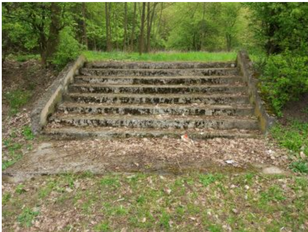
Zdj. nr 49 Schody wschodnie na polanę za projektornią. Schody wymagają licznych napraw ubytków po szkodach mrozowych.
