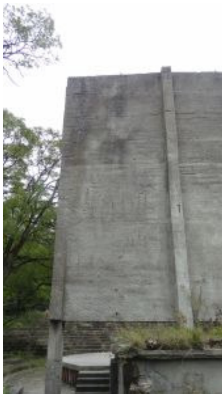
Zdj. nr 9 Tył ekranu od ul. Warsztatowej. Widoczne skorodowane zbrojenia i miejscowe ubytki betonu.
