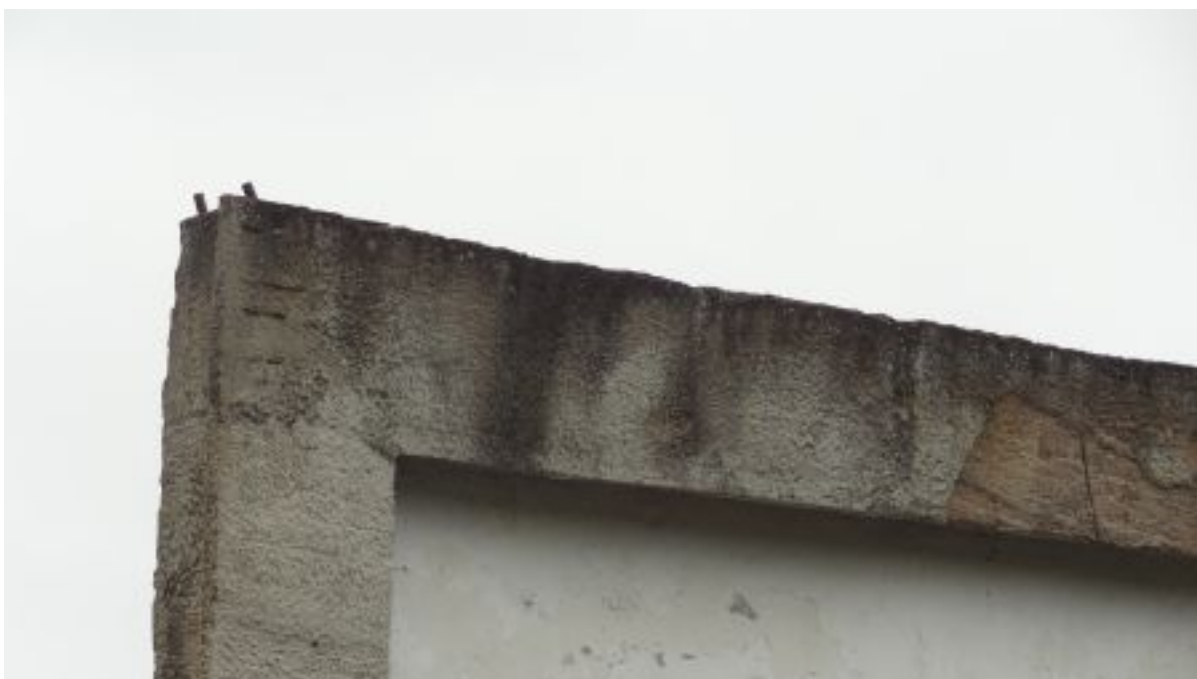
Zdj. nr 14 Górny południowy narożnik obramówki ekranu od strony widowni, posiada widoczne skorodowane zbrojenie, ubytki wyprawy tynkarskiej, ubytki betonu od góry na skutek szkód mrozowych. Z ekranu wystają rurki, prawdopodobnie do montażu flag. Ogólnie ekran posiada uszkodzenia spowodowane brakiem zabezpieczeń przeciwwodnych, jednak są one na tyle niewielkie, że możliwa będzie naprawa konstrukcji żelbetowej ekranu i przywrócenie pierwotnych funkcji.
