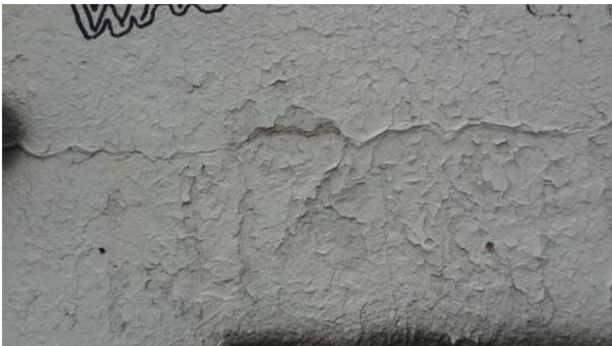
Zdj. nr 7 Ekran od strony widowni jest pomalowany kilkoma warstwami farb emulsyjnych, które częściowo łuszczą się. Na zdjęciu widoczne są poziome rysy, których przyczyną są przerwy technologiczne podczas wylewania betonu. Beton ekranu od strony widowni jest w stanie dobrym.
