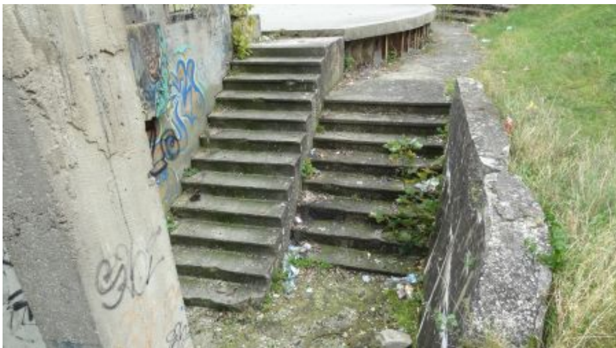
Zdj. nr 21 Schody do fosy południowej posiadają niewielkie ubytki, ogólnie stan dobry. Posadzka betonowa do wymiany. Duże ubytki w ścianie oporowej w miejscach kotwień balustrad. Pęknięć
