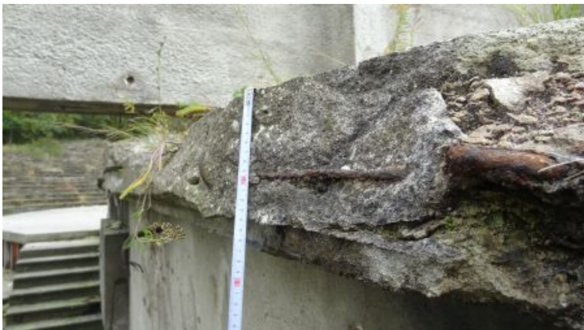
Zdj. nr 25 Zniszczone krawędzie stropu wraz ze zbrojeniem obwodowym, wymagają odtworzenia. Łączna grubość warstw stropowych wynosi 20 cm.
