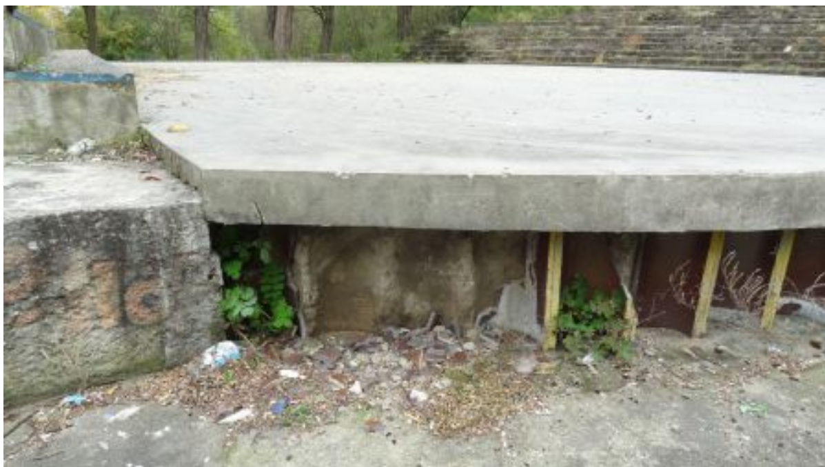
Zdj. nr 37 Ścianka oporowa została wykonana z koryt kamionkowych, które uległy zniszczeniu. Do wymiany nadaje się 28 koryt..
