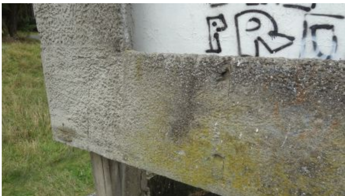
Zdj. Nr 4 Na powierzchni obramowania widoczne jest lekko skorodowane zbrojenie na całej powierzchni żelbetowej obramówki.
