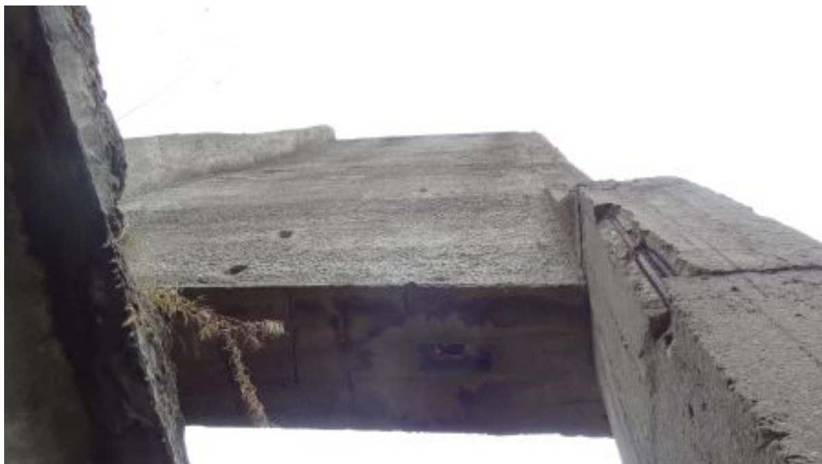
Zdj. nr 11 Słup ekranu od strony południowej. Na skutek korozji zbrojenia, betonowy narożnik uległ zniszczeniu.
