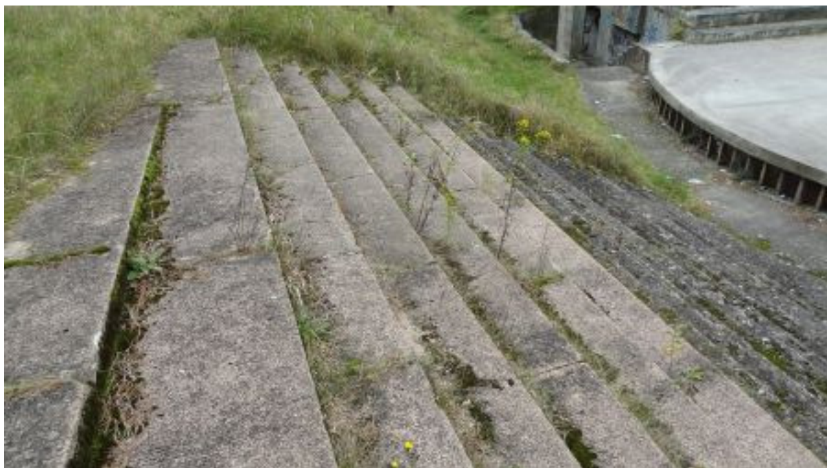
Zdj. nr 42 Trybuna południowa. Górne stopnie zostały wykonane z kanelowanych prefabrykatów, pozostałe zostały wykonane z betonu na miejscu. Stopnie prefabrykowane są w stanie dobrym. Niższe partie schodów wylewanych, posiadają liczne uszkodzenia mrozowe i ubytki. Schody są stabilne i nadają się do przeprowadzenia remontu.
