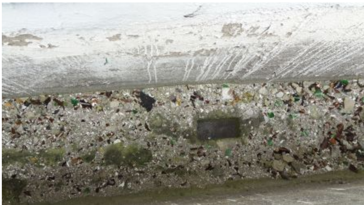
Zdj. nr 3 Koryto między ekranem a jego żelbetową obramowaniem. W korycie znajdują się otwory odwadniające, które zapobiegają gromadzeniu się wód opadowych.
