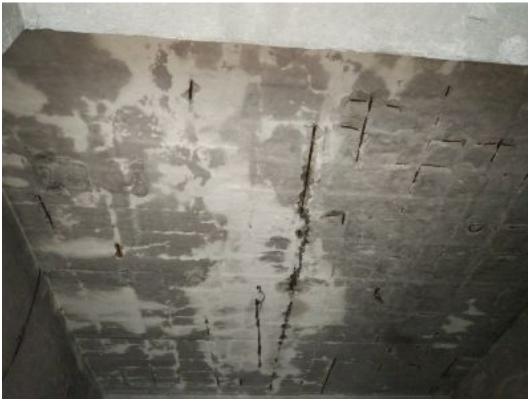
Zdj. nr 29 Podscenie - strop z widocznym zbrojeniem w narożniku północno – zachodnim.
