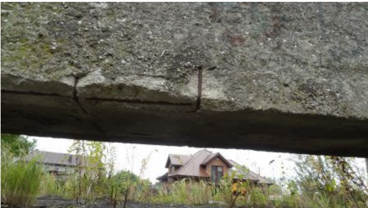
Zdj. nr 8 Spód obramówki ekranu. Widoczne jest lekko skorodowane zbrojenie. W miejscach tych wymagane będą naprawy w systemie PCC.
