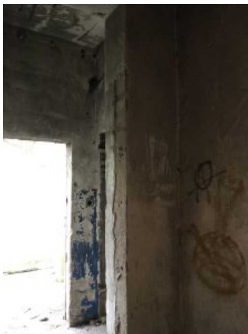
Zdj. nr 34 Wiatrołap przy wejściu południowym. Tynki do wymiany w 50%, ścianki działowe wykonane z cegły dziurawki.
