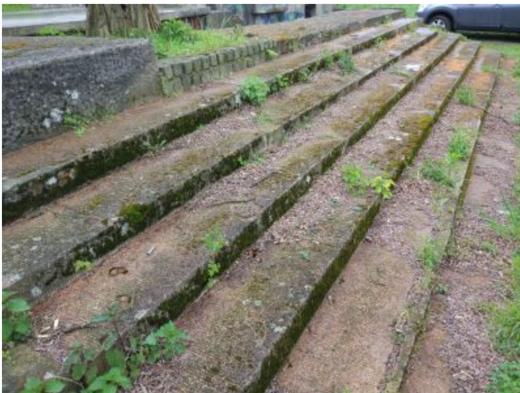
Zdj. nr 44 Mała trybuna północna została zdestabilizowana przez rosnące na niej drzewa i nadaje się do rozbiórki.
