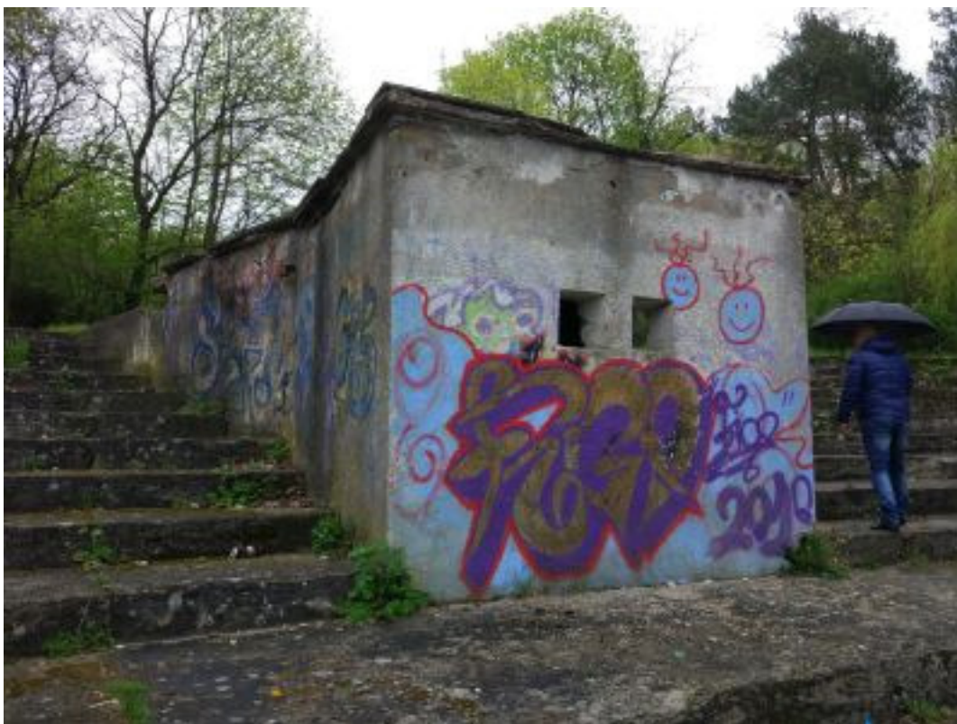
Zdj. nr 45 Budynek projektorni wybudowano z różnych materiałów ( ściany z kratówki i bloczków gazobetonowych ). Południowo-zachodni narożnik dachu jest bardzo uszkodzony.
