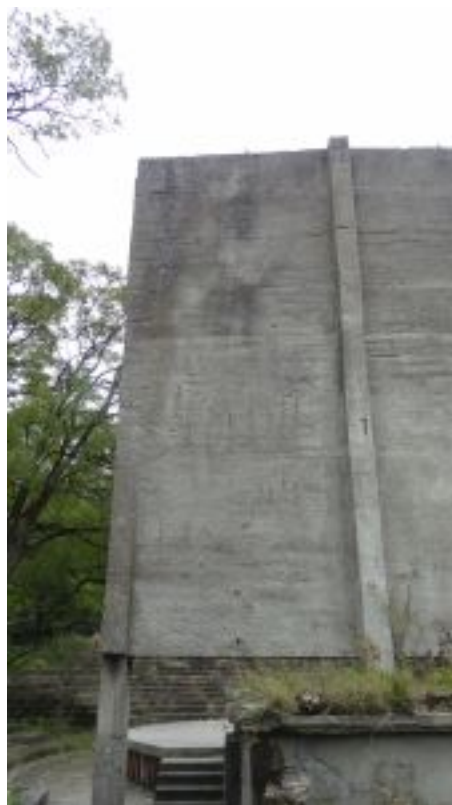
Zdj. nr 9 Tył ekranu od ul. Warsztatowej. Widoczne skorodowane zbrojenia i miejscowe ubytki betonu.
