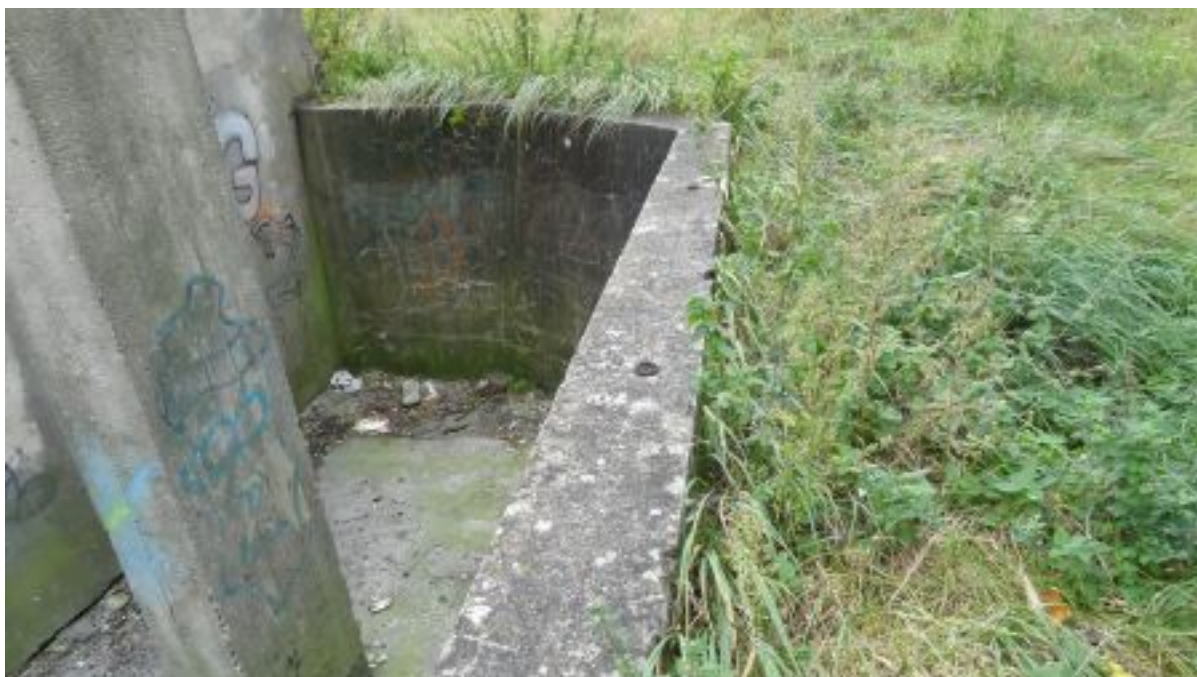
Zdj. nr 19 Ściana oporowa północnej fosy posiada niewielkie rysy oraz wykruszenia w miejscach montażu balustrad.
