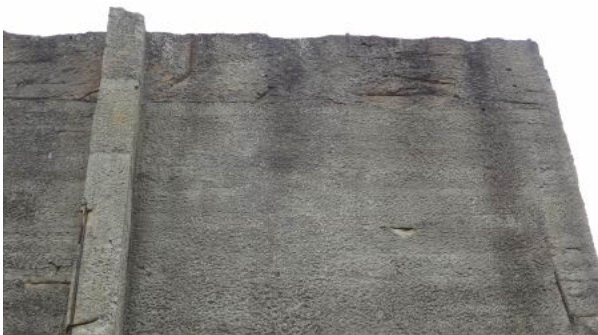
Zdj. nr 10 Tył ekranu od ul. Warsztatowej, narożnik od strony południowej. Widoczne skorodowane zbrojenia i miejscowe ubytki betonu. Widoczna erozja górnych partii ekranu.
