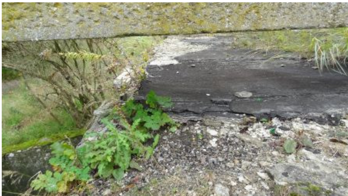
Zdj. nr 22 Południowa krawędź dachu podscenia. Widoczne są resztki papy zniszczony betonowy podkład pod izolacją bitumiczną oraz żużel, który stanowił warstwę wyrównawczą na stropie żelbetowym.
