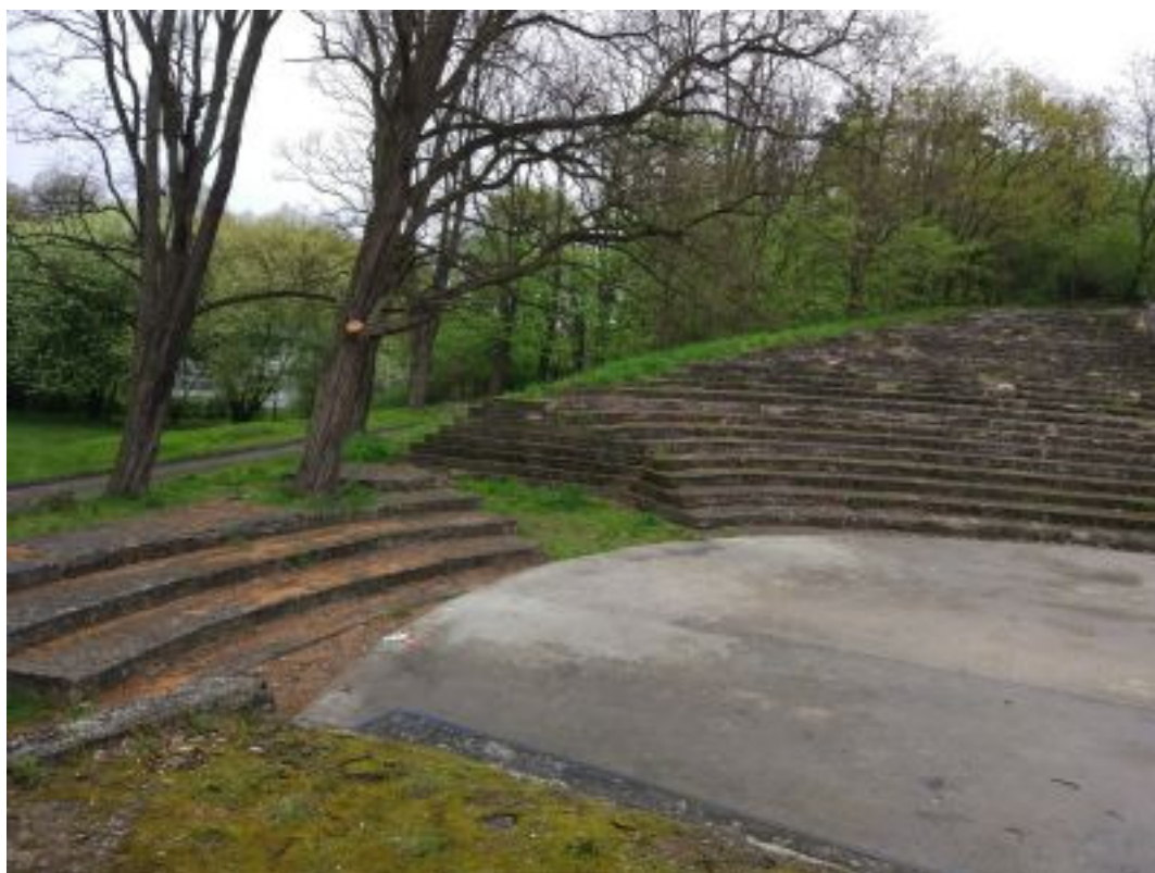
Zdj. nr 43 Mała trybuna północna została zdestabilizowana przez rosnące na niej drzewa i nadaje się do rozbiórki. Na zdjęciu widoczne jest obniżenie północnej części trybuny głównej.
