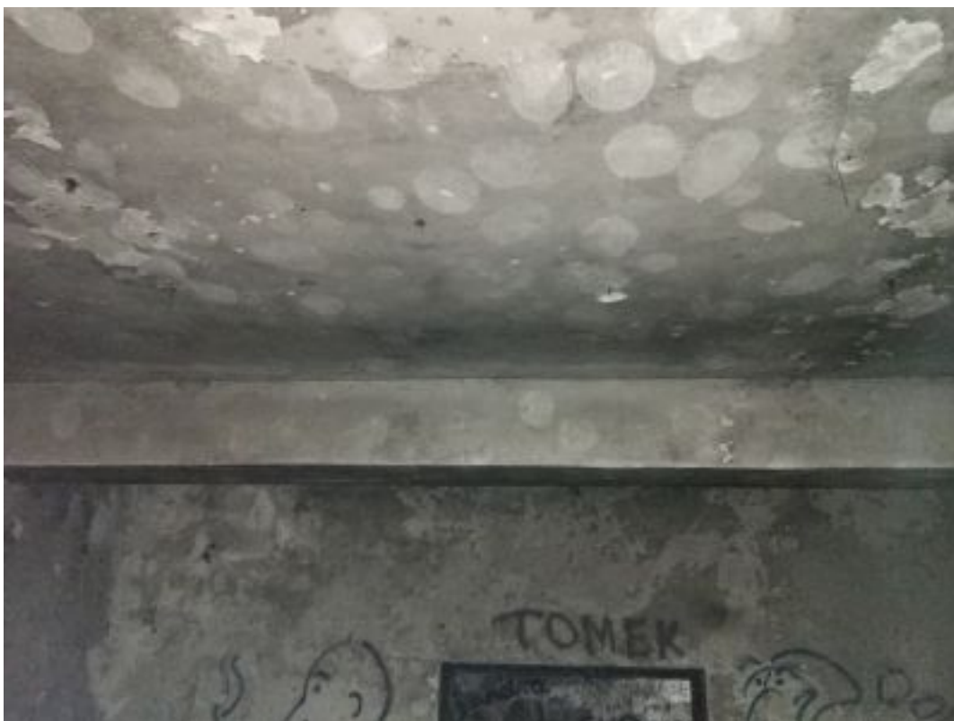
Zdj. nr 32 Strop i podciąg w pomieszczeniu narożnym północno-zachodnim. Stan konstrukcji dobry. Tynki na ścianach i stropach do wymiany w 50 %
