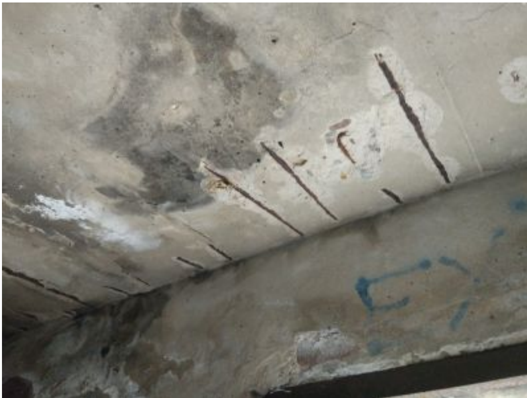
Zdj. nr 47 Projektownia. Brak zabezpieczeń przeciwwodnych na dachu, spowodował mocną erozję stropu i ścian nośnych.
