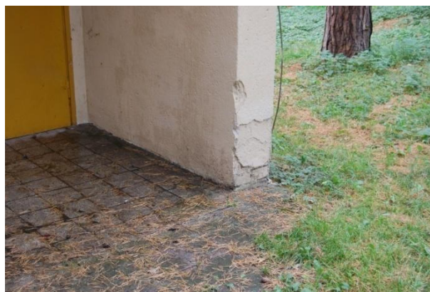
fot.22. ubytki w wyprawkach tynkarskich
