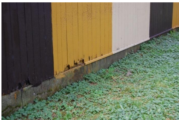
fot.21. korozja biologiczna elewacji drewnianej
