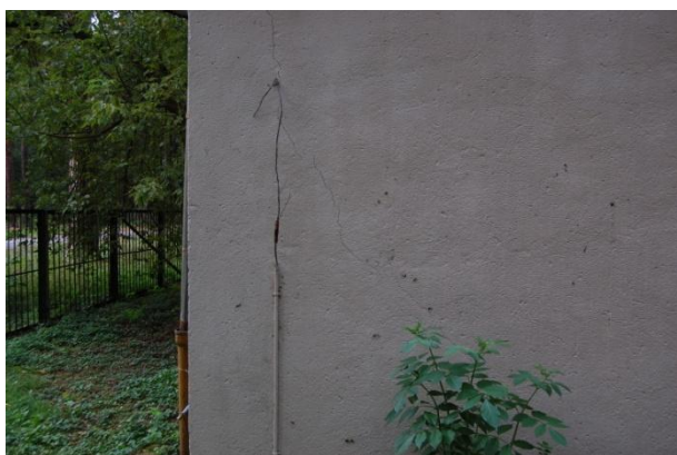
fot.17. zarysowanie ściany
