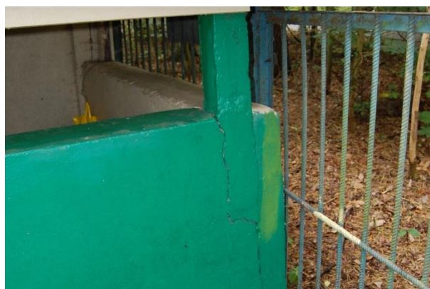
fot.16. ściecie przekroju słupa
