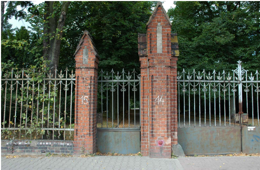
Fot.15 Przęsło 15 Bramka wejściowa – podobnie jak w bramie dolna płycina metalowa do wymiany
