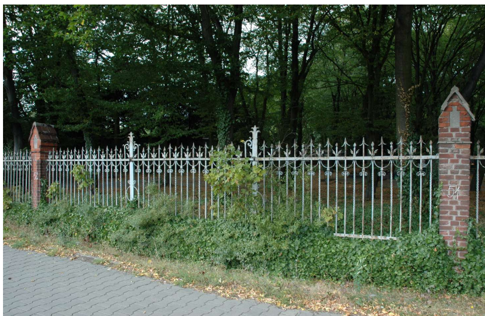
Fot.52 Przęsło 52 – słup 51 cały do wymurowania na wzór starego, oryginalnego słupa
