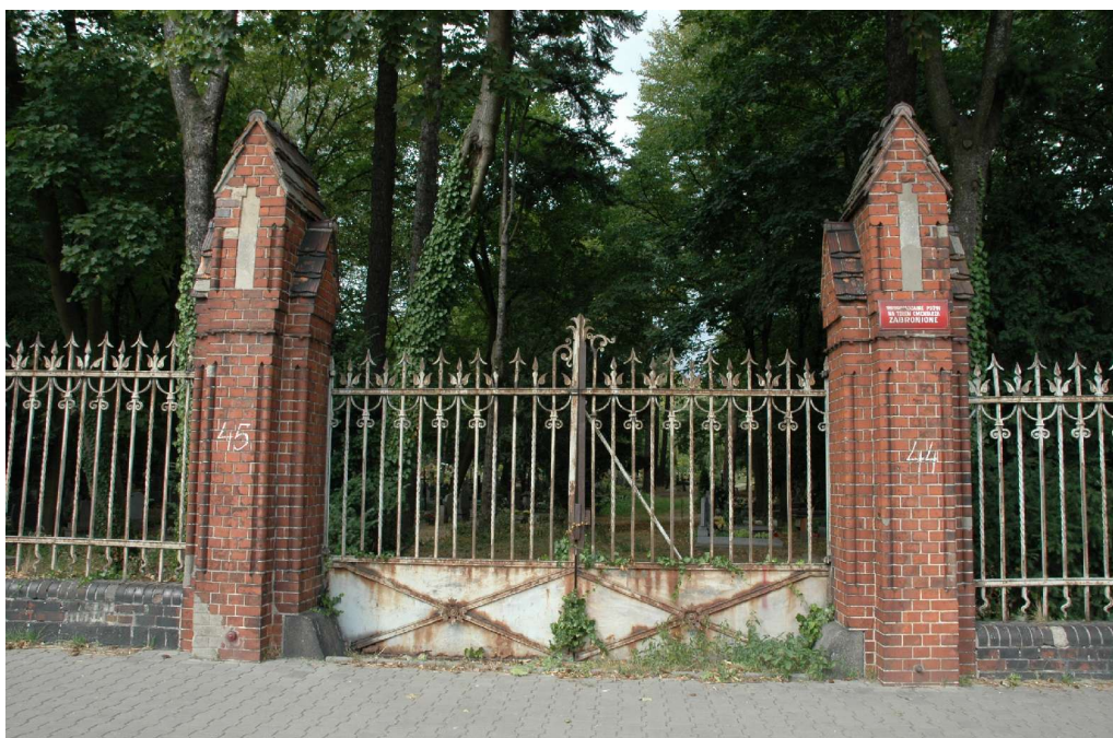
Fot.45 Przesło 45 Brama Cmentarza – płyty metalowe bramy do wymiany, elementy ozdobne do konserwacji
