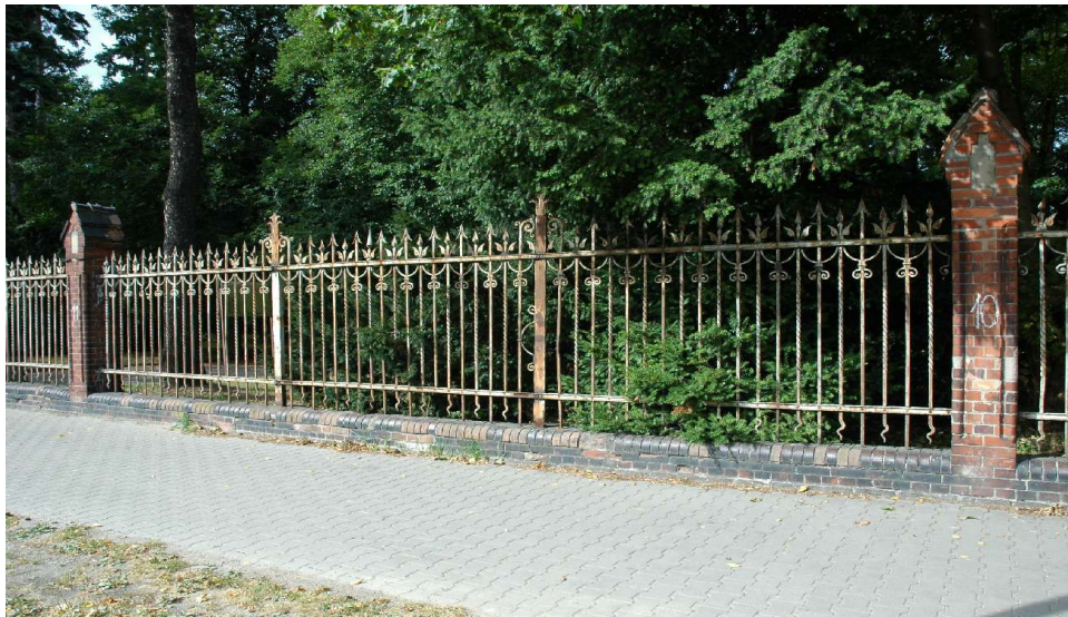
Fot.11 Przesło 11 Wstawki cementowe “porozsadzały część cokołową ogrodzenia, widoczny w wielu miejscach brak spoin
