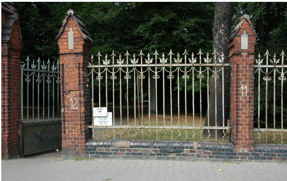
Fot.12 Przesło 12 Rozsadzony cokół przez wstawki cementowe, wyraźna nierówność muru
