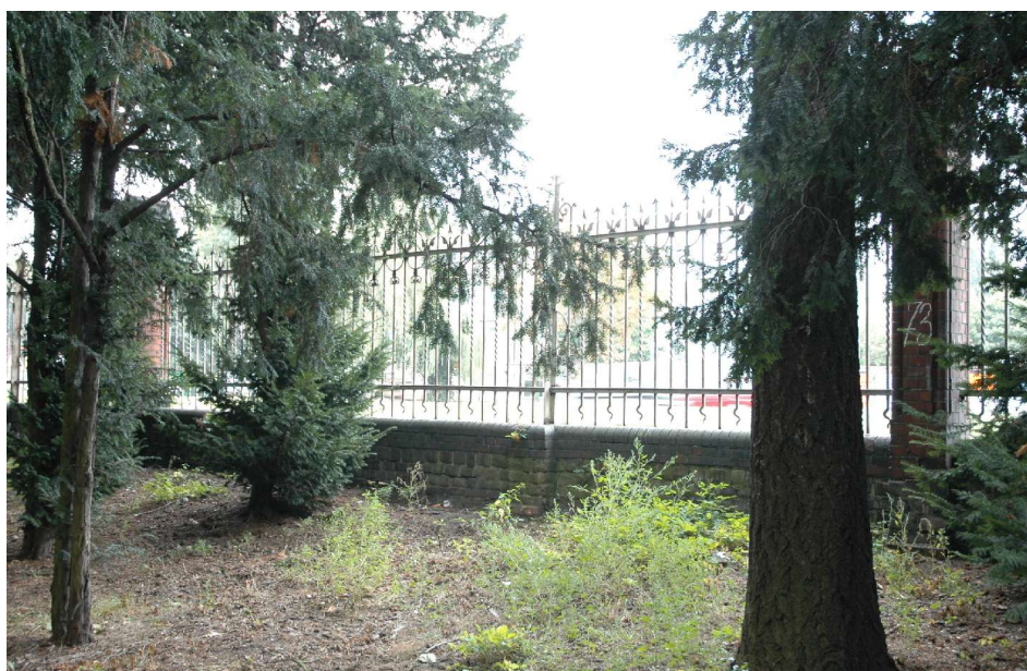
Fot.76 Przęsło 74 – w części cokołowej wyraźnie widoczny zielony nalot mchów, glonów i porostów
