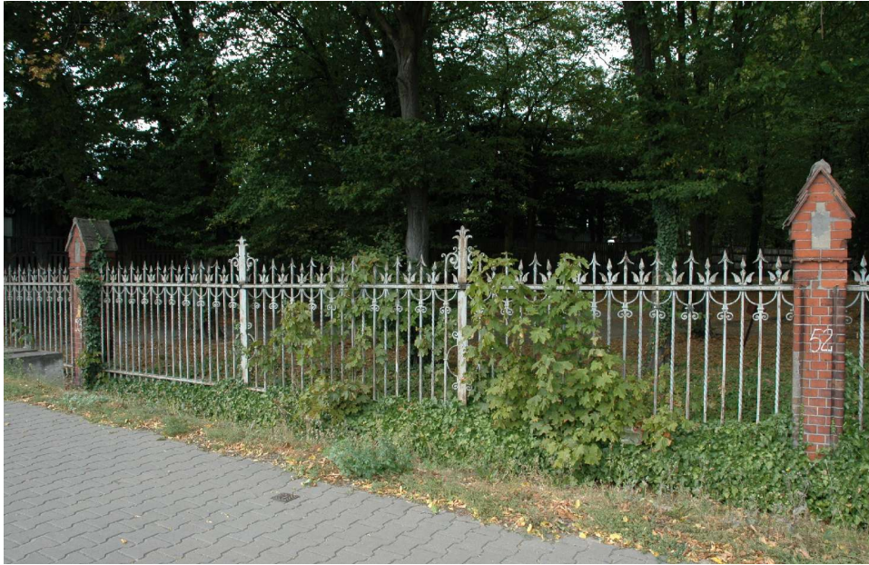
Fot.53 Przęsło 53 – część cokołowa zaszypana ziemią
