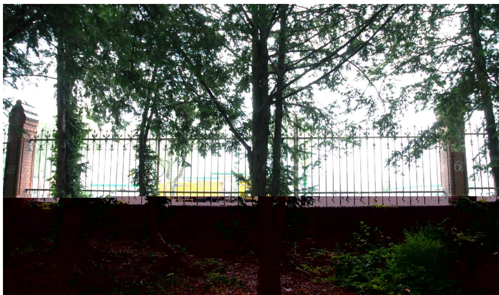
Fot.71 Przęsło69 – bardzo wysoko eksponowany cokół, widoczna podmurówka ceglana w złym stanie zachowania
