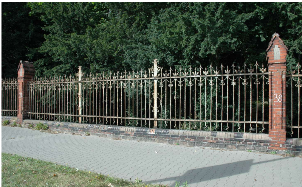
Fot.39 Przęsło 39 – duża ilość kształtek cementowych cokołu do wymiany
