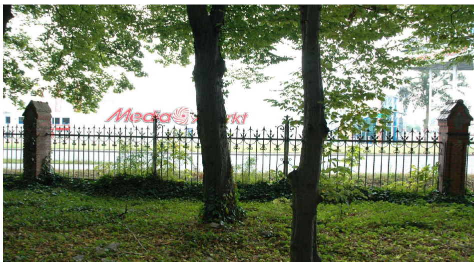
Fot.58 Przęsło 56 – cokół zasypany ziemią
