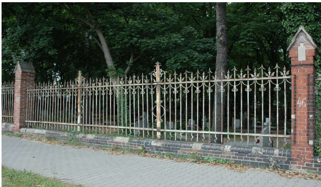
Fot.47 Przęsło 47 – słup 46 górna partia daszku do przemurowania
