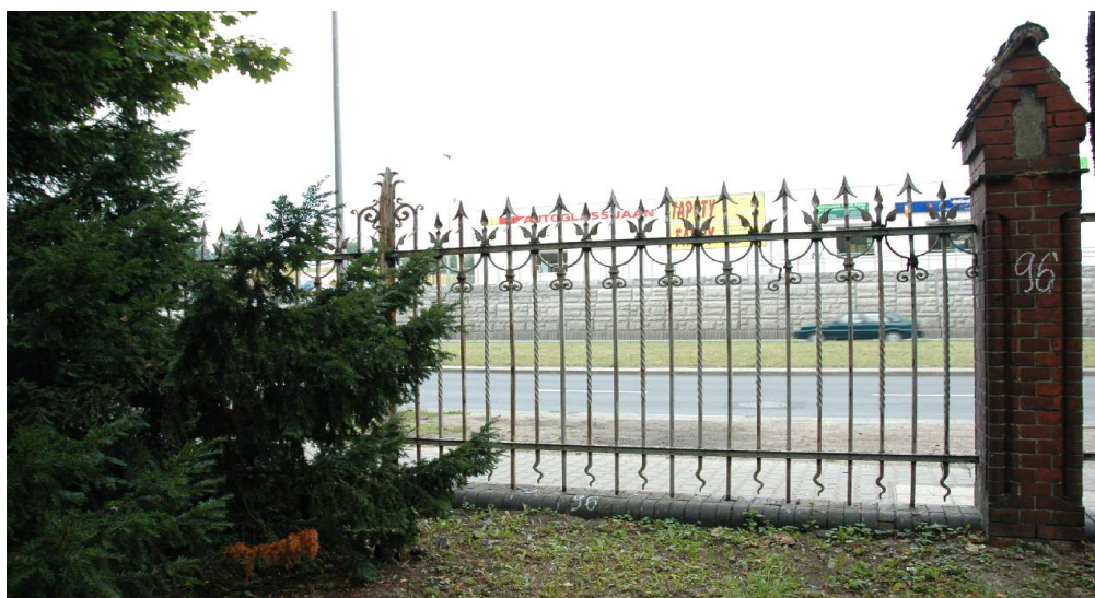
Fot.100 Przesło 97 (część zakryta roślinnością), cokół zasypany częściowo ziemią
