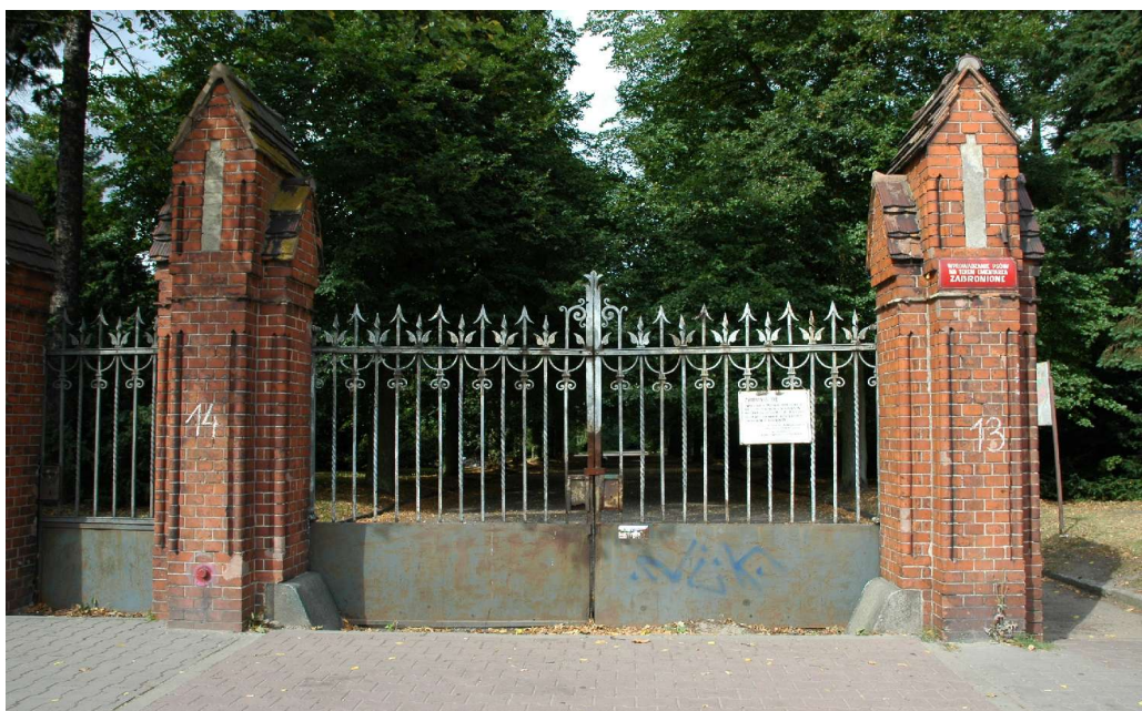
Fot.14 Przęsło 14 Brama Główna Dolne metalowe płyty bramy do wymiany – silna korozja metalu
