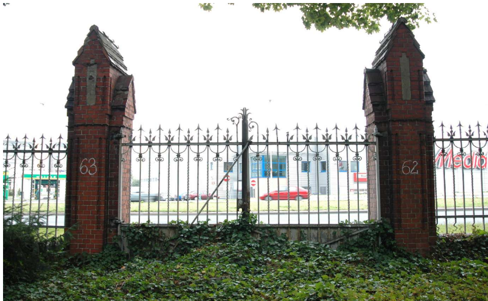
Fot.65 Przęsło 63 – Brama – tylna część, silnie porośnięta bluszczem
