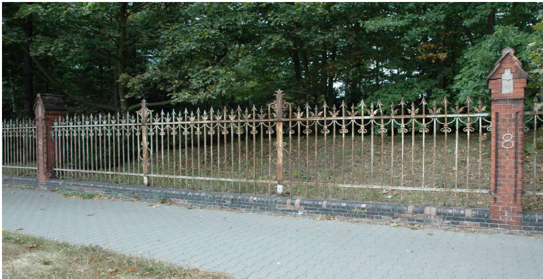
Fot.9 Przęsło dziewiąte. Silna, bardzo czytelna korozja metalu.
