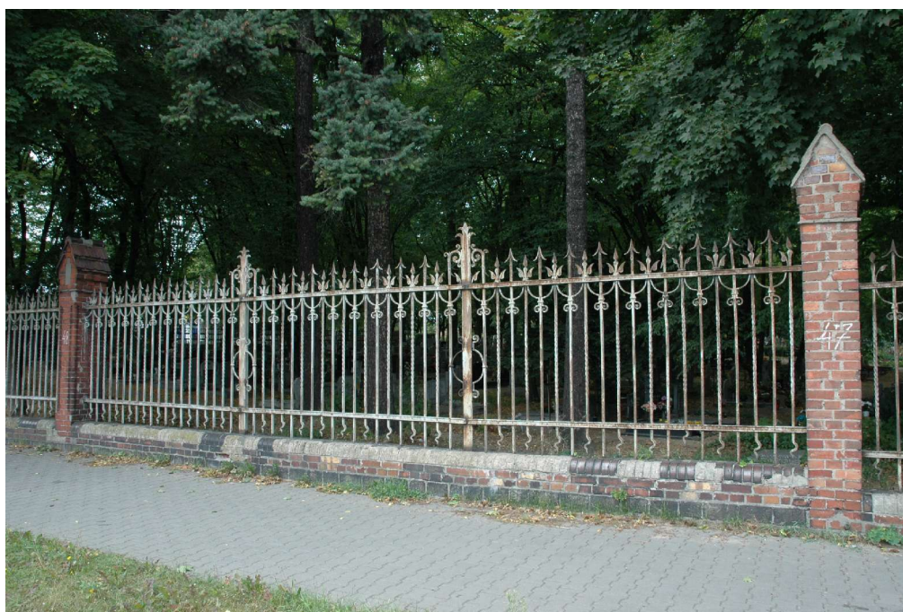
Fot. 48 Przęsło 48 – słup 47 cały do wymurowania na wzór słupa oryginalnego, bardzo duża ilość kształtek cementowych do usunięcia
